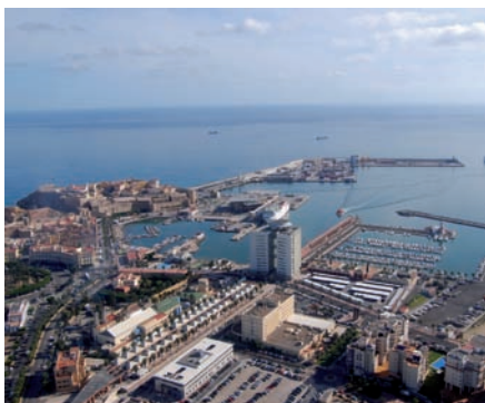
La ampliación del Puerto de Melilla prevé ganar 51 hectáreas al mar, disponer de un calado de 18 metros en el canal de navegación y 1.350 metros de línea de atraque.
